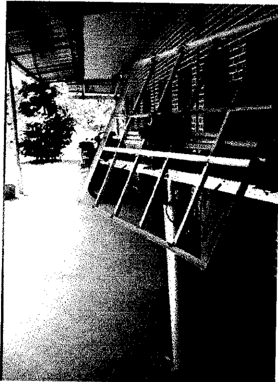
รูปที่ 3.9 การประกอบโครงแผงโซลาร์เซลล์
