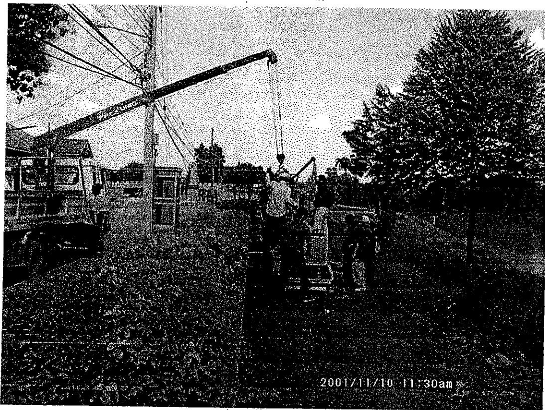
รูปที่ จ-7 รูปการเคลื่อนย้ายและติดตั้งเครื่องขุดเจาะ
