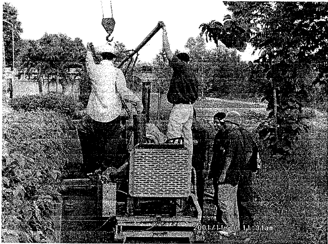
รูปที่ จ-8 รูปการเคลื่อนย้ายและติดตั้งเครื่องขุดเจาะ
