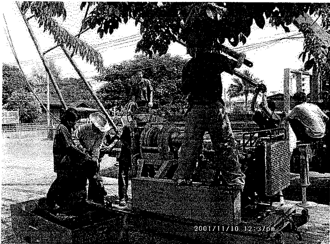
รูปที่ จ-9 รูปการเคลื่อนย้ายและติดตั้งเครื่องขุดเจาะ
