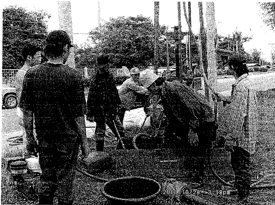
รูปที่ ๑-1 รูปขณะทำการเจาะสำรวจ
