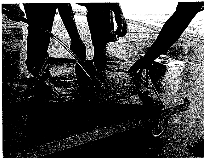
รูปที่ ๑-4 แสดงการล้างทรายเพื่อการผลิตคอนกรีต
