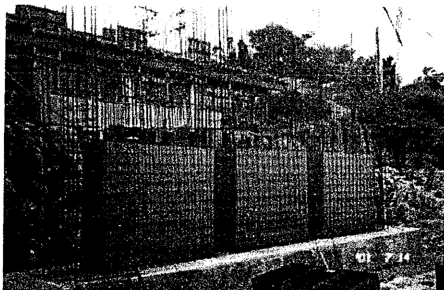
รูปที่ 5.24 การนำไม้แบบมาทำกำแพงตอม่อแบบกลางใน
