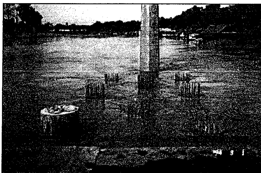
รูปที่ 5.18 เสาเข็มกลางแม่น้ำ ที่ทำการสกัดหัวเสาเข็ม จะสังเกตได้ว่าเสาเข็มกลางแม่น้ำไม่มีการถอนปลอกเหล็กออก เนื่องจากทำได้ลำบากและป้องกันเสาเข็มในส่วนที่อยู่ใต้น้ำ
