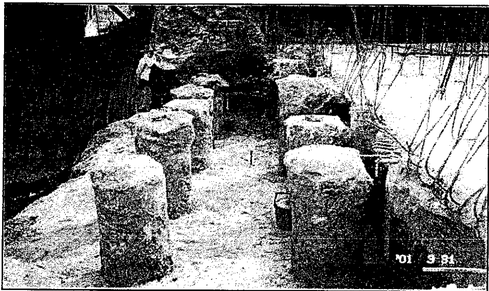
รูปที่ 5.2 ฐานรากค่อม่อเก่าที่จะทำการขุดออก
