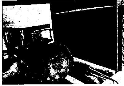
รูปที่ 4.15 แสดงภาพด้านในของ Coil ร้อน มีพัดเกาะ
