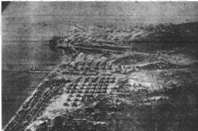
ภาพ 10 กัมปงโสมระหว่างการก่อสร้างท่าเรือในเดือนสิงหาคม ค.ศ.1957
