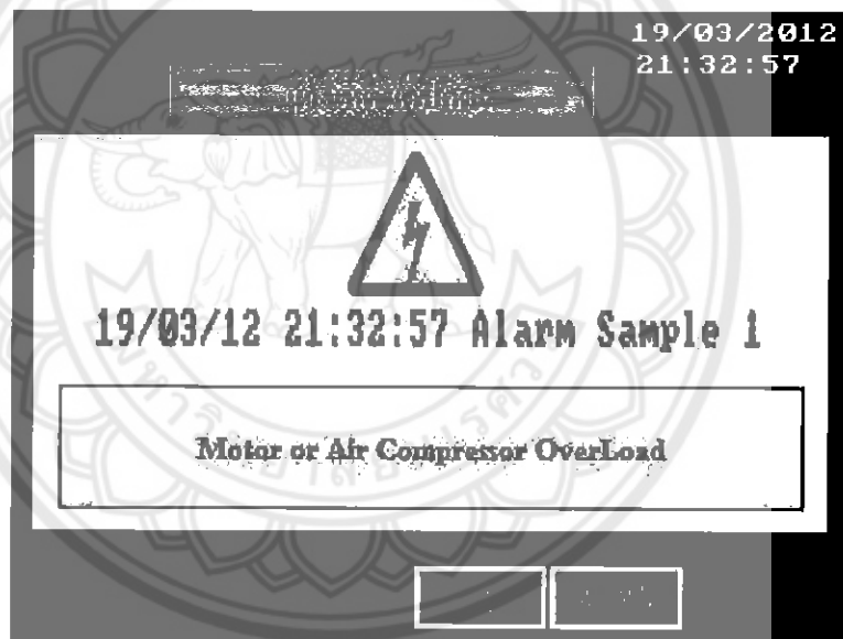
รูปที่ 3.11 หน้าจอแจ้งเตือนสถานะกระแสเกินของมอเตอร์ และปั๊มลม
