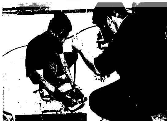
รูปที่ 3-29 ทำการดำเนินการราบหัวคอนกรีตและลดช่องว่างในเนื้อคอนกรีต
