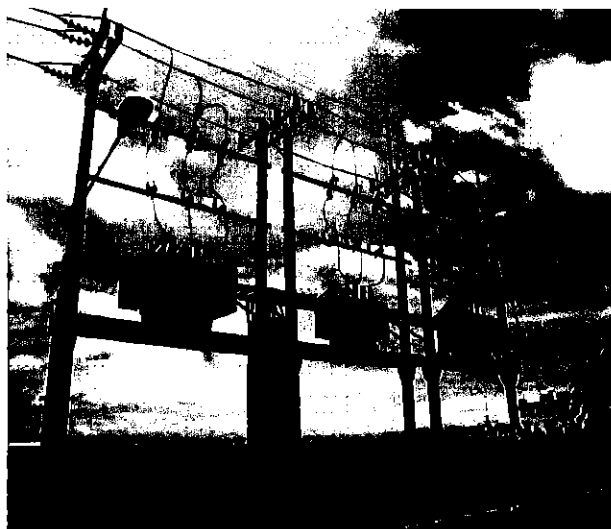
รูปที่ 2.24 หม้อแปลงแบบนั่งร้าน
