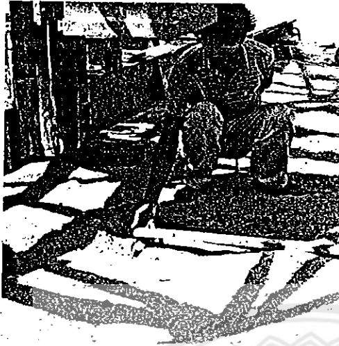
หมุดเสาเข็มที่ทำไว้แล้ว ควรตรวจสอบอีก ครั้งก่อนตอกเพื่อป้องกันการเยื้องศูนย์
