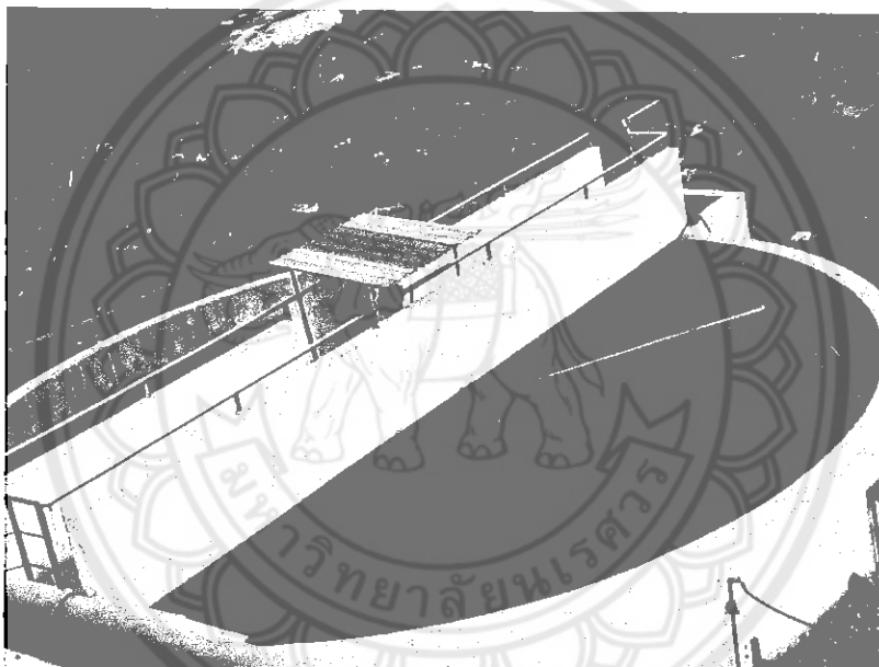
รูปที่ 2.5 ถังตกตะกอนแบบวงกลม
