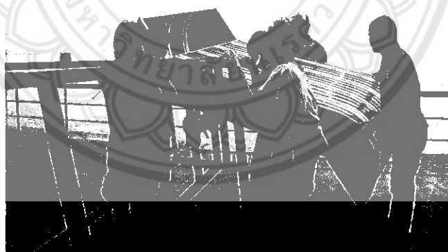
รูปที่ 4.26 การประกอบใบพัดกังหันลมเข้ากับเพลาส่งกำลัง
