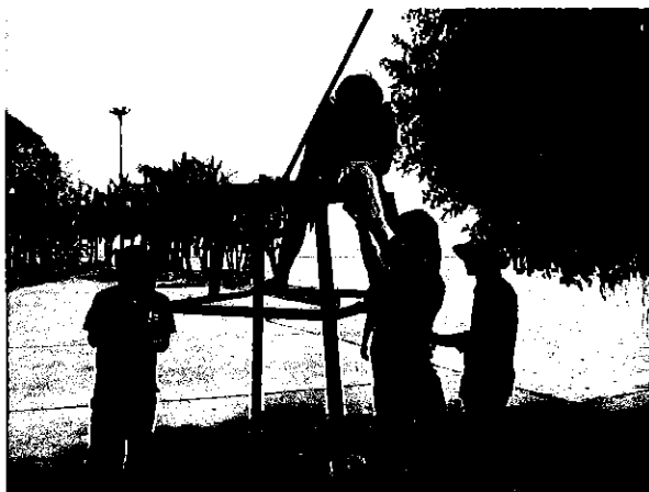
รูปที่ 4.23 การประกอบโครงสร้างฐานของกังหันลม
