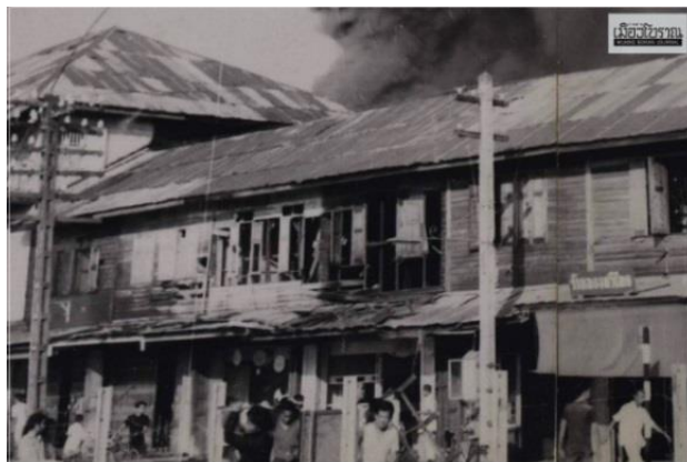
ภาพ 38 จากรูปภาพที่ 38 เป็นการแสดงเหตุการณ์เพลิงไหม้อาคารตลาดทำอิฐ รูปแบบห้องแถวไม้ ครั้งที่ 2 เมื่อ พ.ศ. 2508 โดยชวนศักดิ์ ไทวนิชย์ เจ้าของร้านขายยาจีอันจันโอสถ ใช้กล้องฟิล์มสัญชาติ เยอรมันชื่อ Rolli
