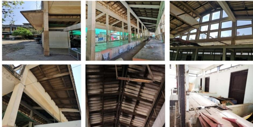
ภาพ 85 แสดงวัสดุโครงสร้างเสาและหลังคาคอนกรีต โดยวัสดุมุ่งเป็นกระเบื้องลอนคู่ทั้งหมด
