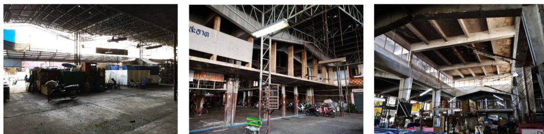
ภาพ 48 แสดงวัสดุโครงสร้างเสาและหลังคาโครงถักเหล็ก (Truuss) (ซ้าย) การเชื่อมต่อของโครงสร้างคอนกรีตอาคารเดิมและโครงสร้างเหล็กส่วนต่อเติม (กลาง) โครงสร้างเสาและหลังคาคอนกรีต (ขวา) โดยวัสดุมุ่งเป็นกระเบื้องลอนคู่ทั้งหมด
