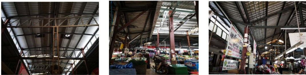
ภาพ 62 แสดงวัสดุโครงสร้างเสาคอนกรีต โครงหลังคาถักไม้ (Truuss) (ซ้าย) เสาไม้ โครงหลังคาไม้ และจุดเชื่อมต่ออาคาร (กลาง) เสาคอนกรีต โครงหลังคาเหล็ก (ขวา) โดยวัสดุมุ่งเป็นเมทัลชีทสลั๊บ แผ่นโป๊วรงแสงทั้งหมด
