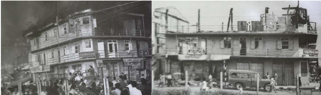
ภาพ 36 จากรูปภาพที่ 36 เป็นการแสดงเหตุการณ์เพลิงไหม้อาคารตลาดทำอิฐ รูปแบบ ตึกแถว คอนกรีต ครั้งที่ 2 เมื่อ พ.ศ. 2508 โดย วิเชียร แสงวิวัฒน์เจริญ
