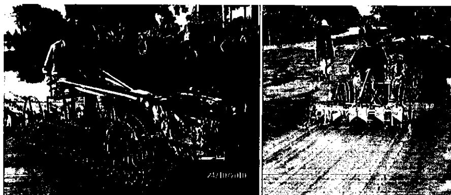
รูปที่ 3.9 การทดสอบเครื่องโรยเมล็ดข้าววงอกแบบต่อพ่วงรถไถเดินตามในแปลงนา
