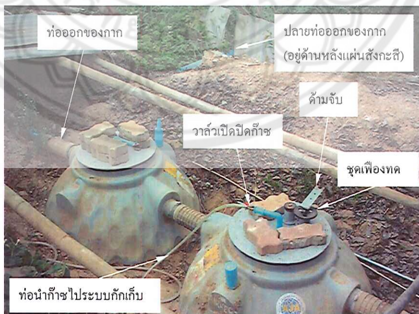
ภาพที่ 3.10 อีกมุมหนึ่งของถังหมักก๊าซชีวภาพ
